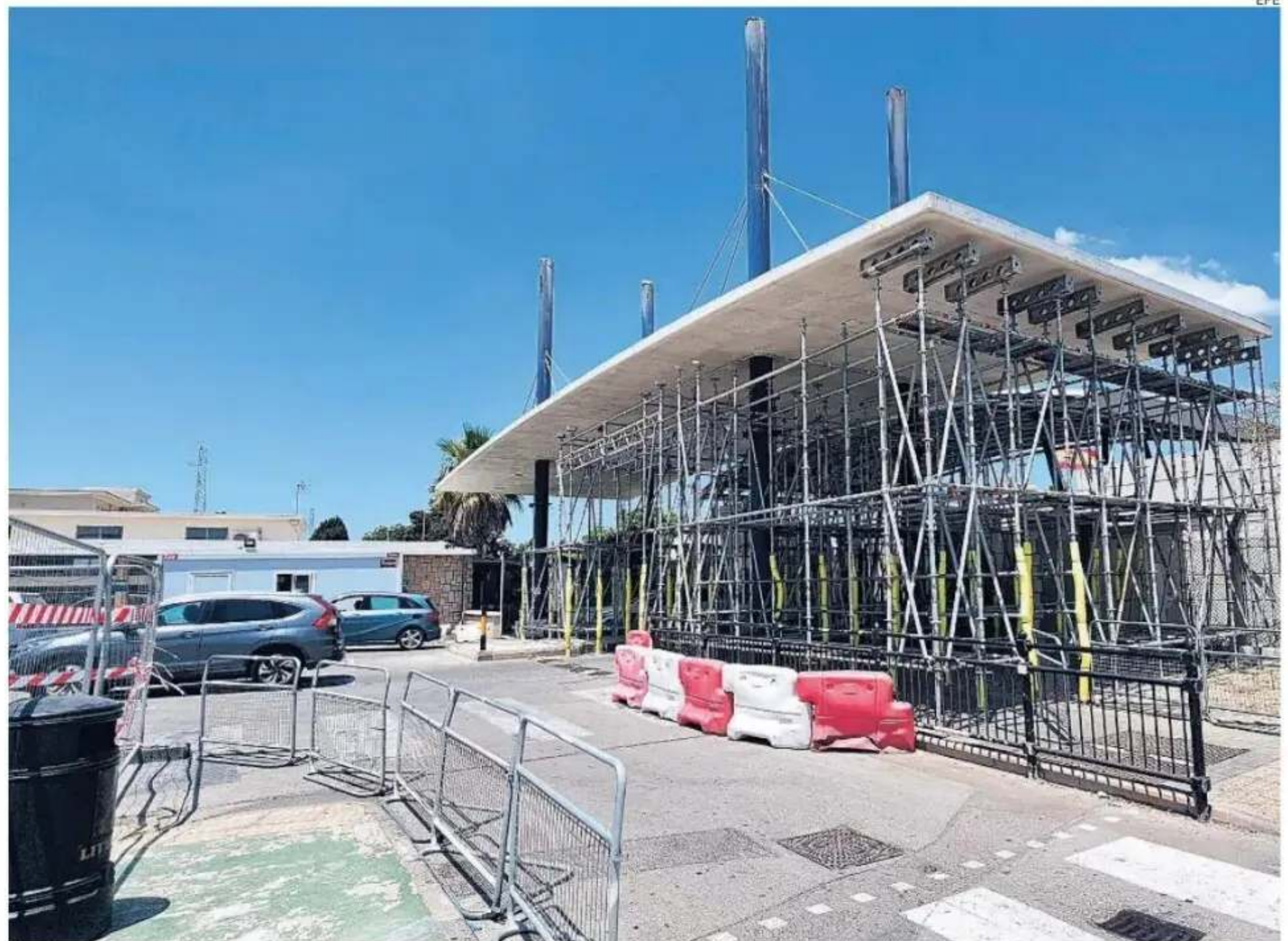
Ya han comenzado en la zona los trabajos de retirada de la Verja
